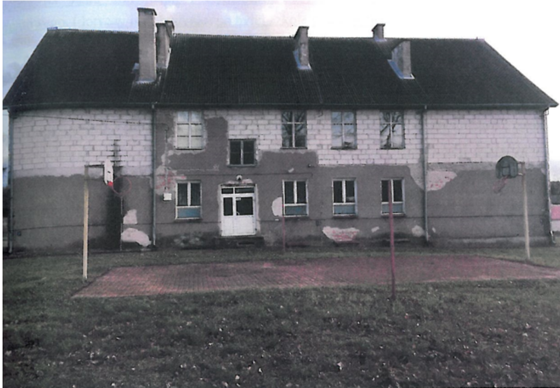
Fot. 3 Elewacja północno-zachodnia
