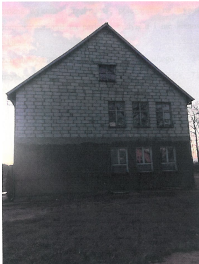
Fot. 4 Elewacja północno-wschodnia
