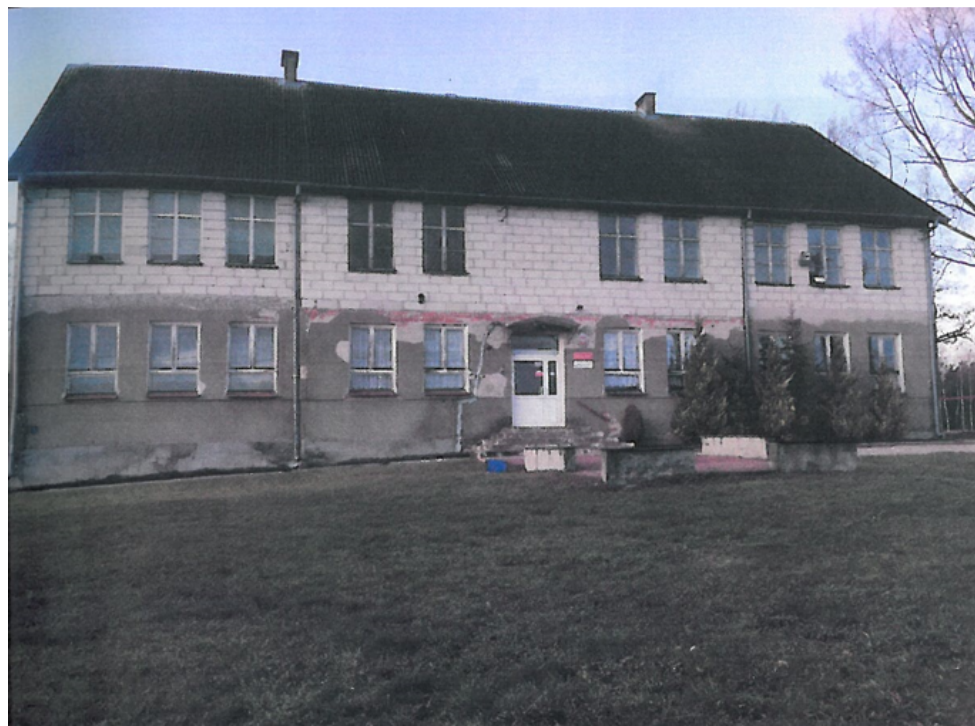
Fot. 1 Elewacja południowo-wschodnia
