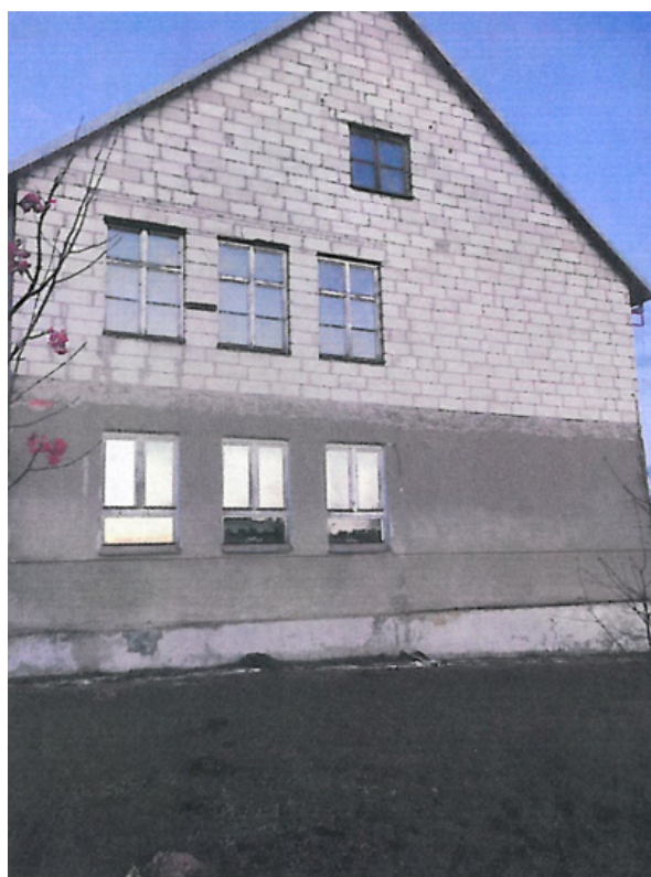
Fot. 2 Elewacja południowo-zachodnia
